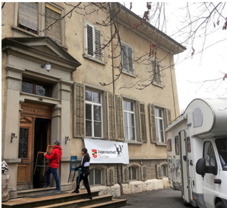
Der neue Jugendraum befindet sich im historischen Schulgebäude A an der Nauenstrasse 1 in Tann.
